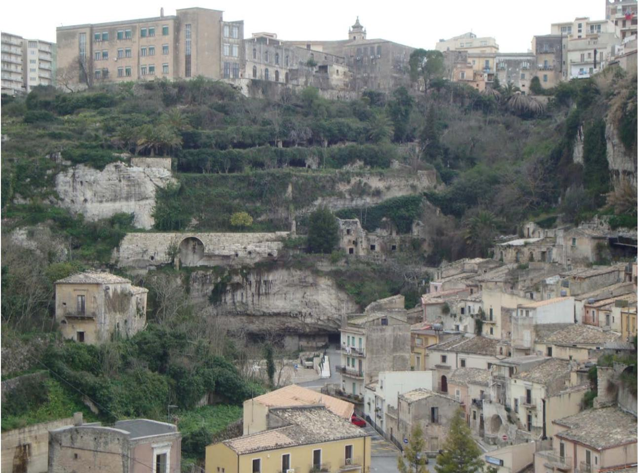
Figura 3.6 – Ragusa. Cavità impostate su pareti sub verticali sulle quali insistono manufatti
