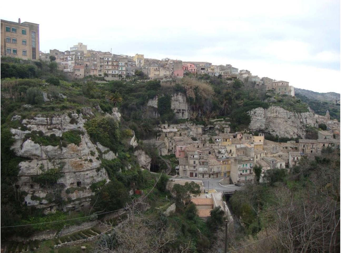
Figura 3.7 - Ragusa . Pareti sub verticali sulle quali e ai piedi delle quali si ergono numerosi edifici, a luoghi interessate da fenomeni di crollo.
