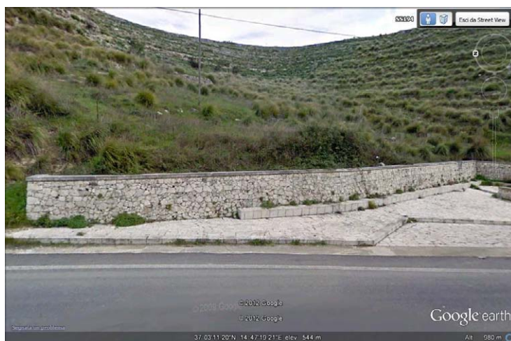
Fig. 8.12– Immagine Street View (Google Earth™) della scarpata A (vista dal piede).
