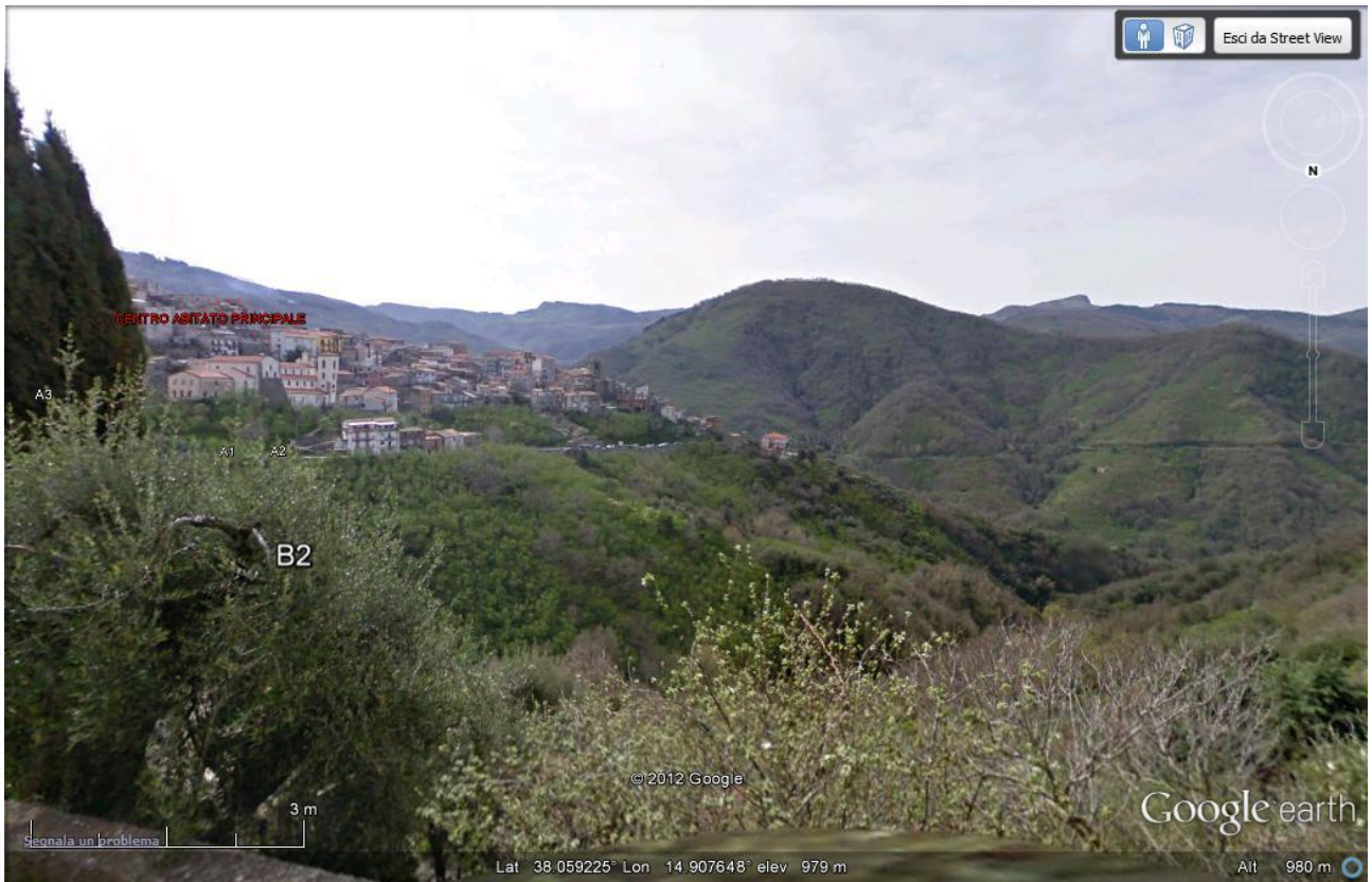
Fig. 8.12 – Immagine Street View (Google Earth™) della scarpata B.
