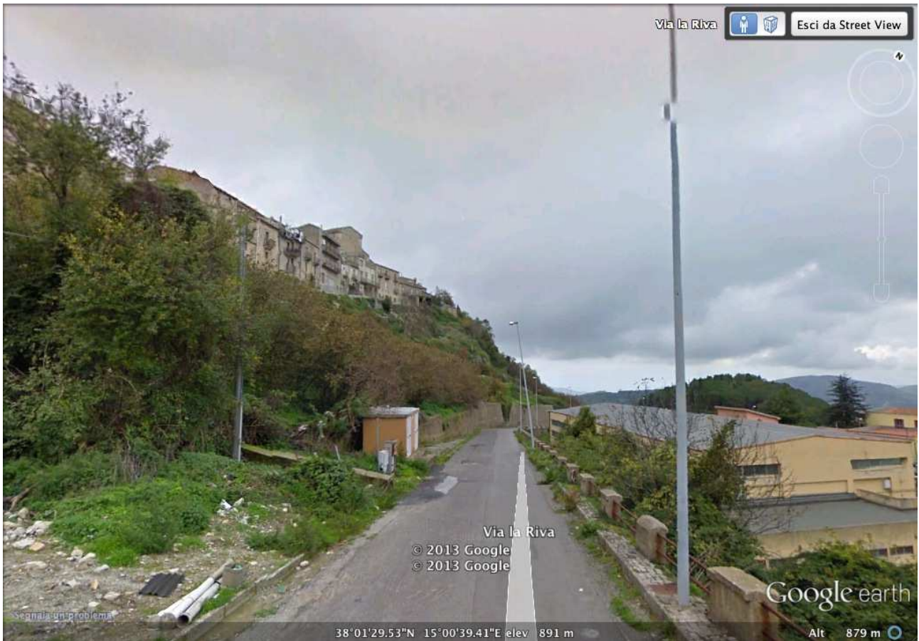
Fig. 8.8 – Immagine Street View (Google Earth™) della scarpata A.
