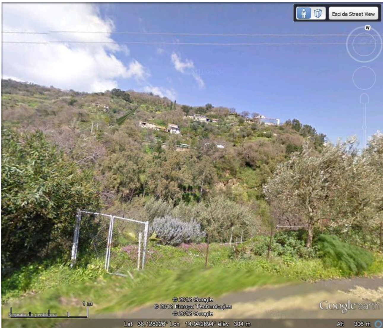
Fig. 8.14 – Immagine Street View (Google Earth™) della scarpata C.
