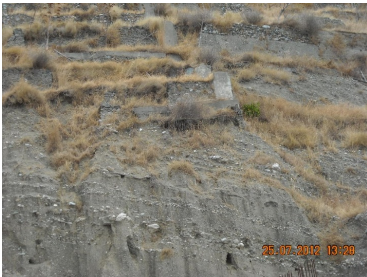
Foto 2 - Affioramento della formazione di Messina nei pressi della frazione Rocchenere. Si osserva una struttura stratificata di depositi prevalentemente sabbiosi a fronte di una irregolare distribuzione granulometrica.
