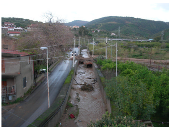
Falcone: vista da nord della Saia Feliciotto prima della rottura dell'argine. Da notare il restringimento causato dalle strutture di attraversamento del torrente
