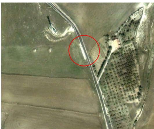
Settembre 2006: si nota un intervento di “consolidamento” lungo la strada rurale, con bitumatura
