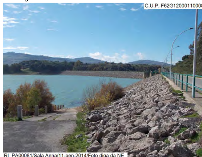
Foto diga da NE
