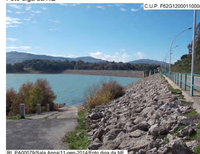
Foto diga da NE
