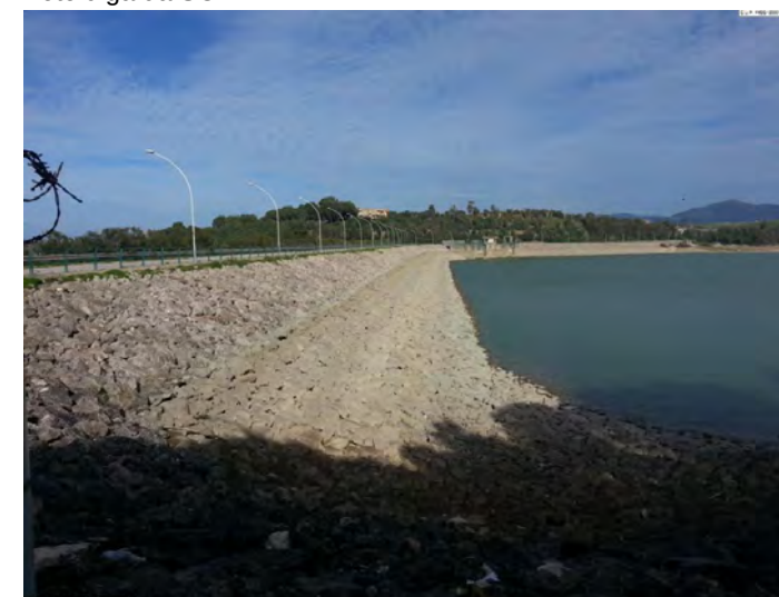
Foto diga da SO
