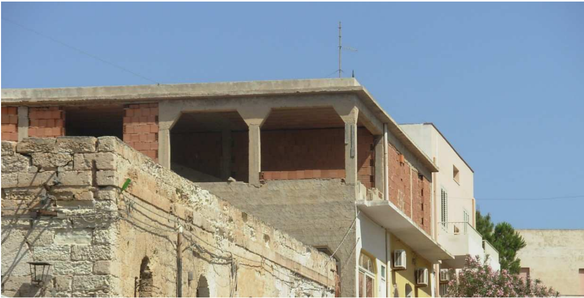
Fig. 7. Edificio in c.a. con struttura intelaiata progettata per soli carichi verticali.
