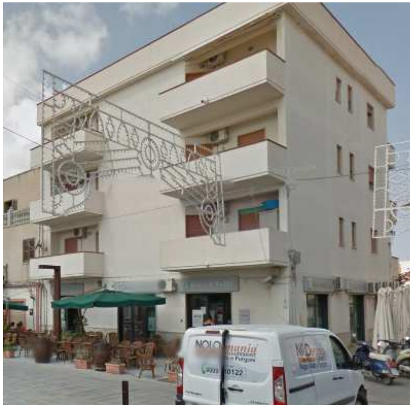
Fig. 8. Edificio in c.a. a 3 elevazioni.
